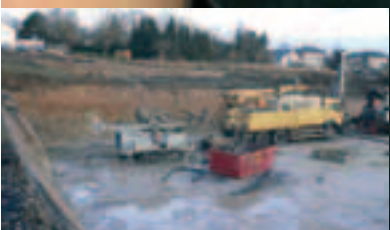
Ein neues Bürogebäude entsteht
